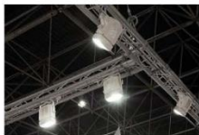
Beleuchtungssystem: Punkttraversen mit HQI Strahlern
