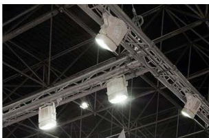
Beleuchtungssystem: Punkttraversen mit HQI Strahlern
